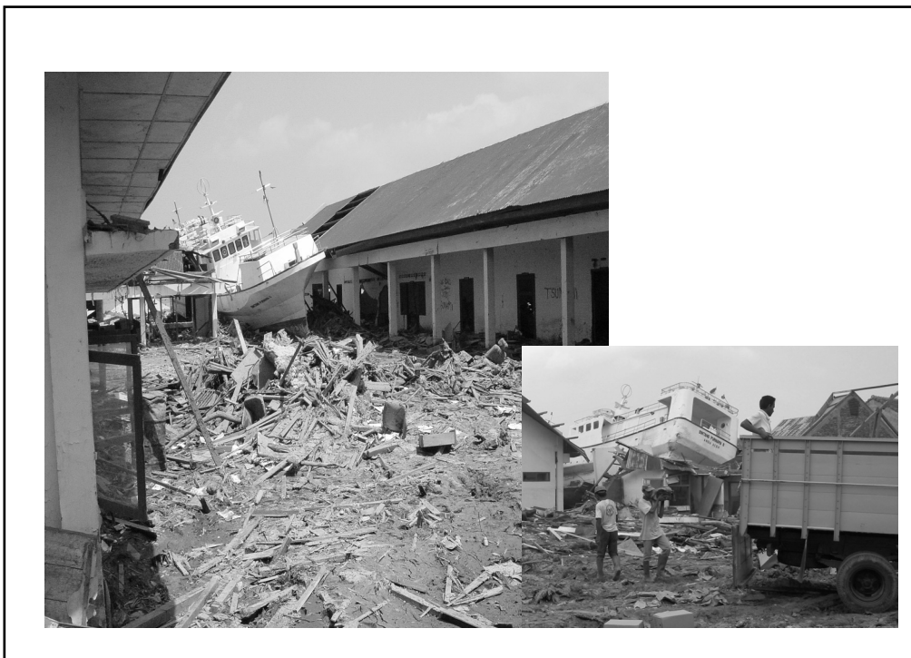
写真2 津波被害を受けた国家土地庁 BPN バンダ・アチェ市事務所
