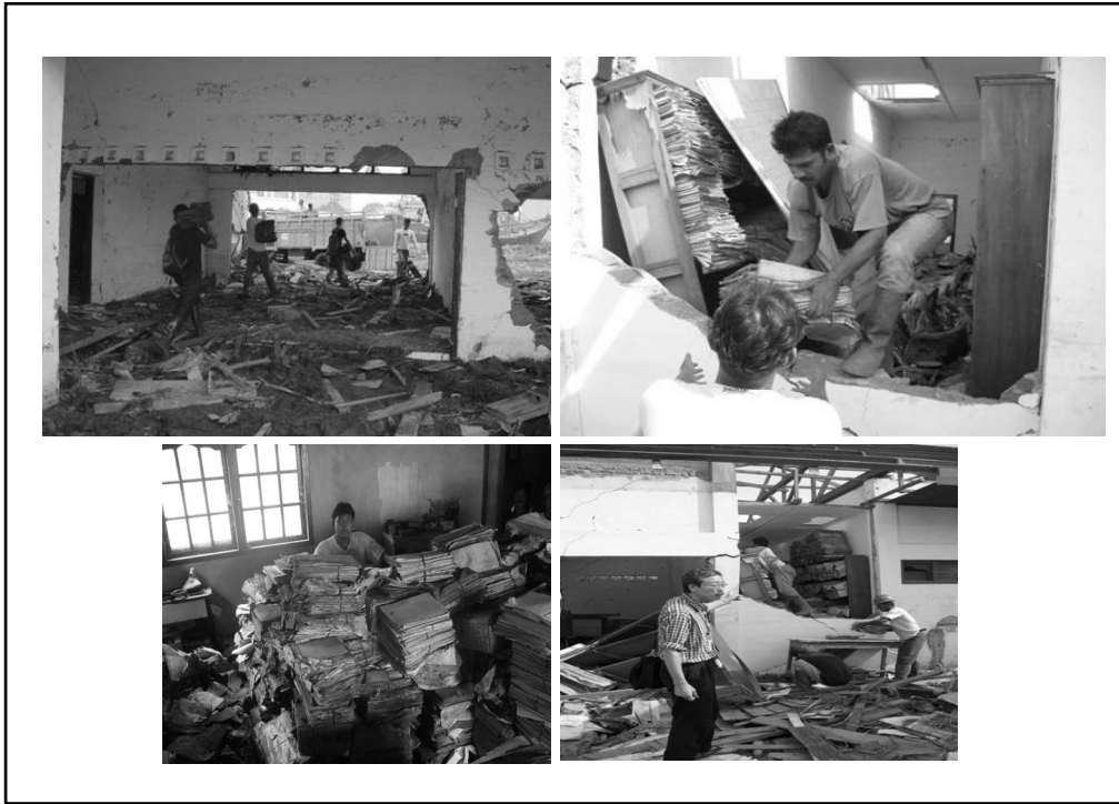
写真5 津波から1ヶ月 被災建物からの土地台帳救出を、JICA 事業として着手
