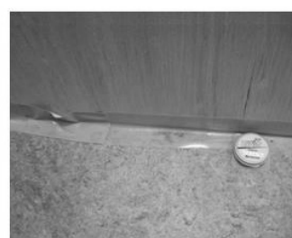
床と壁板との隙間塞ぎ
